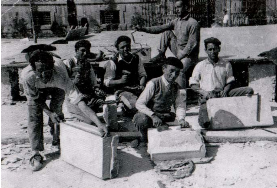
Canteros de El Palmar en La Glorieta (Murcia). Están labrando las piedras con las que se hicieron las fuentes que hoy existen.
