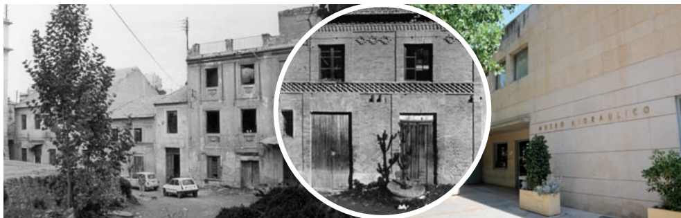
Fachada de los molinos
