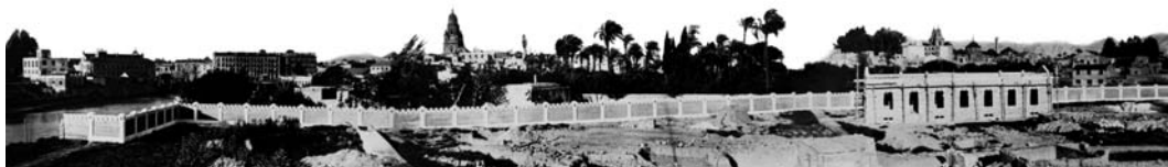
■ Cuartel de Artillería en construcción en 1923
