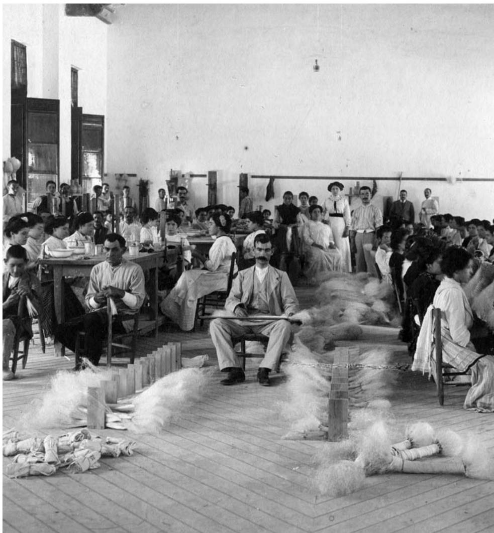
Interior de la fábrica con los obreros
