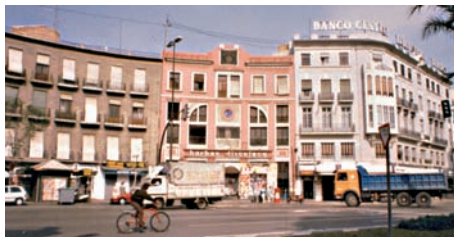
Fachada del antiguo cine Iniesta, plaza González Conde
