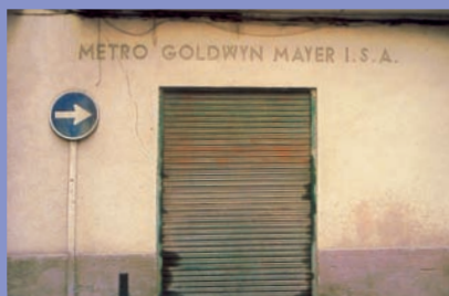
Almacén Metro Goldwyn Mayer, calle del Carmen
