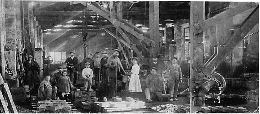
Interior de la fábrica hacia 1910
