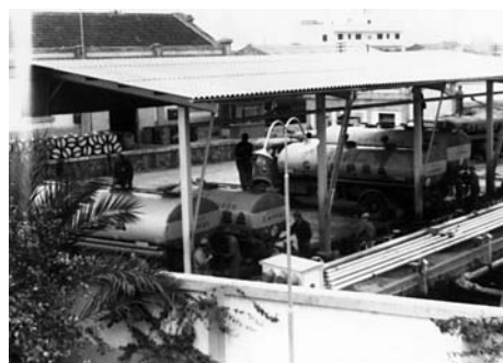
Cargadero de camiones, instalaciones de Campsa
