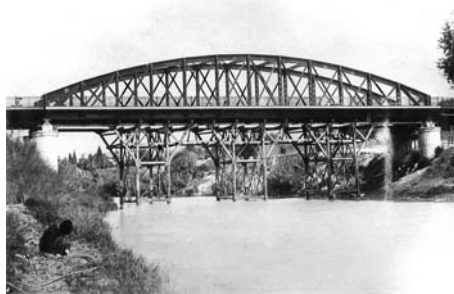
■ Puente Nuevo en construcción, hacia 1900
