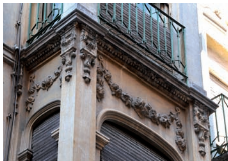
■ Detalle de una fachada en la calle Gracia
