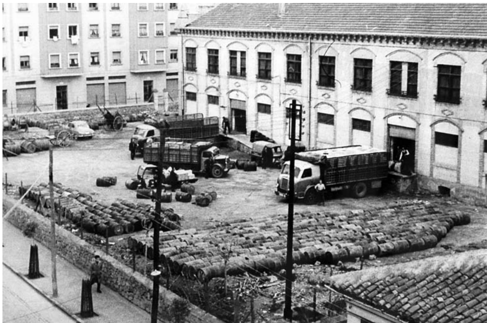
Almacén de Antonio Gómez Guillamón, paseo Marqués de Corvera
