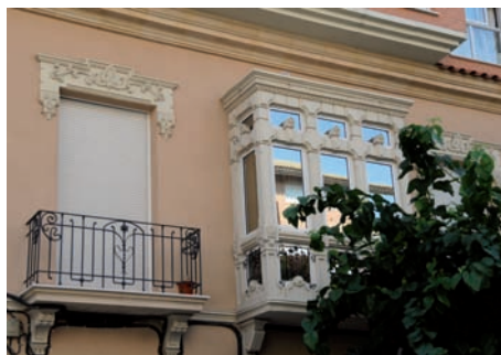
■ Balcón y mirador de una fachada en el paseo Marqués de Corvera
