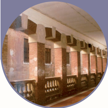
■ Columnas del claustro
