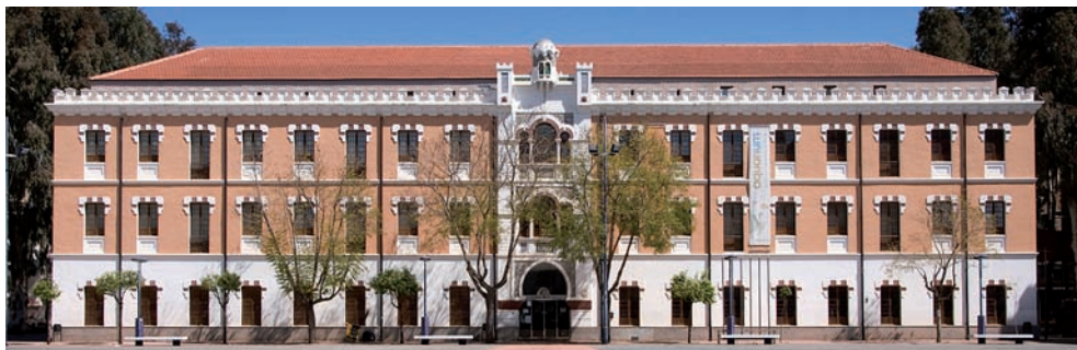
Panorámica de un pabellón restaurado
